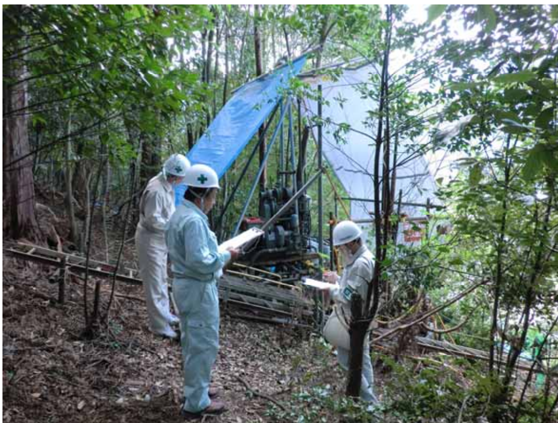
安全パトロールの実施状況
